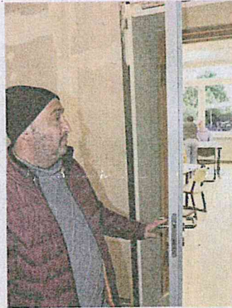
Der Hausmeister zeigt eine neue Brandschutztür.
